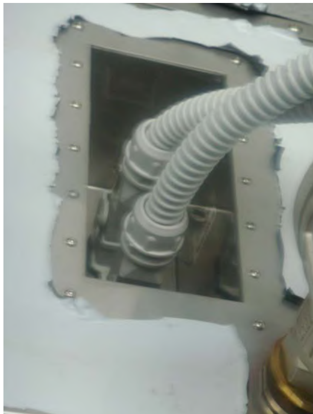
Foto collegamento cavi sul trasmettitore.
