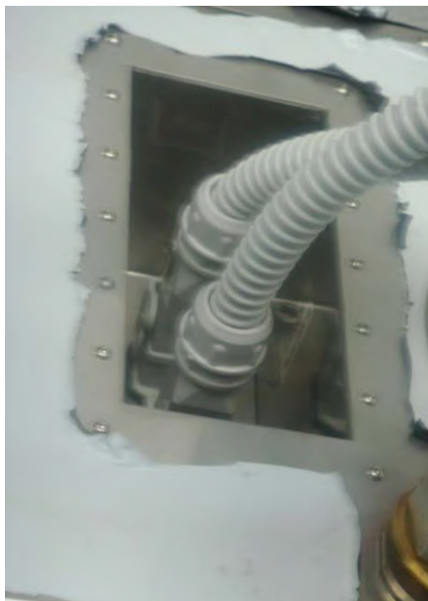
Foto collegamento cavi sul trasmettitore.
